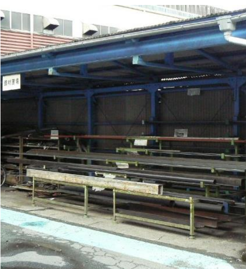
鋼材置場から作業場まで 10mの距離がある
